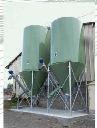
Silos acier pour alimentation désileuse
