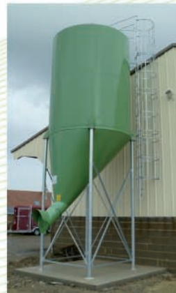
Silo acier déporté reprise extérieure
