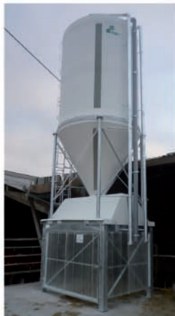
Silo polyester T.E. 2 aliments avec bardage translucide
