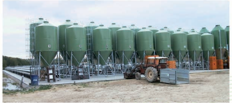
Silos acier élevage cunicole
