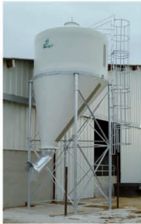
Silo polyester déporté reprise extérieure
