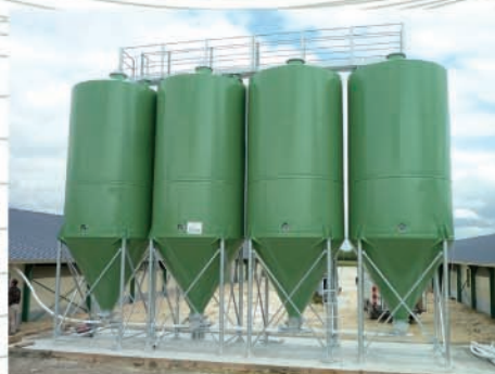
Silos acier avec passerelle commune
